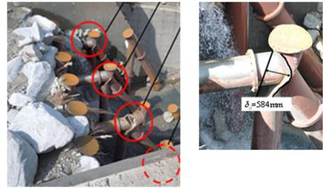
図4 押し込み座屈の景況
