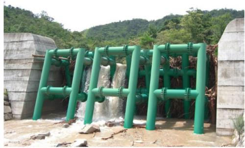
図 1 鋼製透過型砂防堰堤
