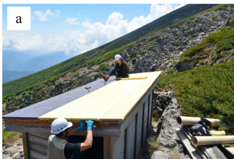
図6 御嶽山におけるアラミド繊維織物を用いた補強の様子 (a: 王滝村9合目避難小屋, b: 石室山荘) [9]
