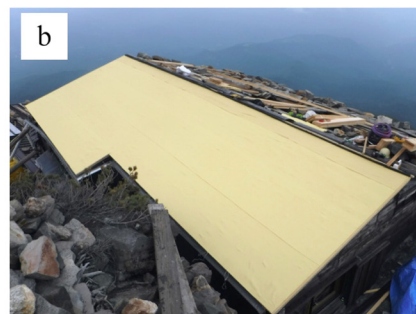
図6 御嶽山におけるアラミド繊維織物を用いた補強の様子 (a: 王滝村9合目避難小屋, b: 石室山荘) [9]
