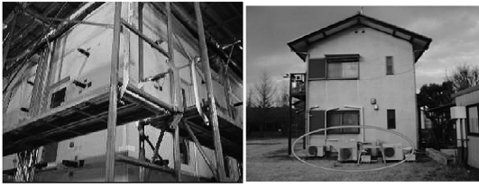
図 13 ヒートポンプ機器の計測（建築研究所） （左：実験室実験，右：実験住戸における実測）
