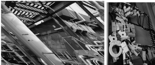
図 19 実測対象のコージェネレーションと電力測定状況
