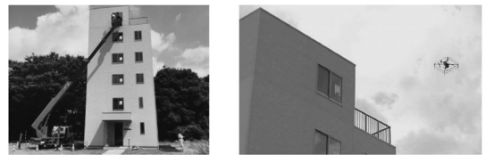
高所作業（目視点検） ドローン撮影点検（カメラ撮影）
