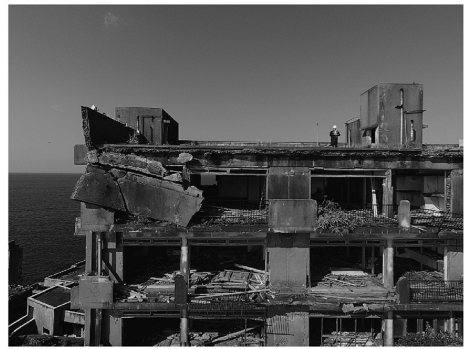
図8 外壁・パラペット破損の状況（端島3号棟）
