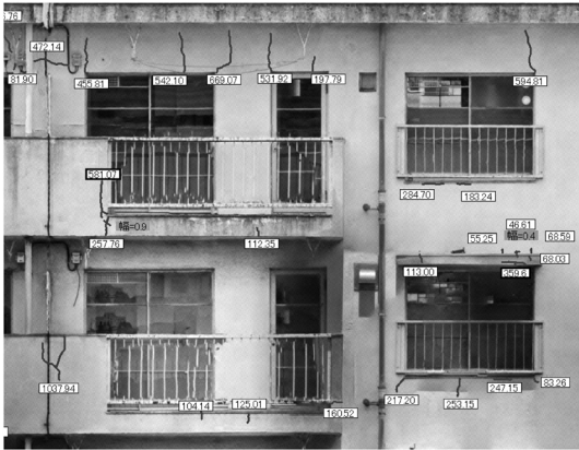
図6 南面外壁のひび割れ図（オルソ画像）
