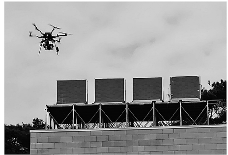
図13 屋根面に設置したタイル張り試験体におけるドローンによる調査
