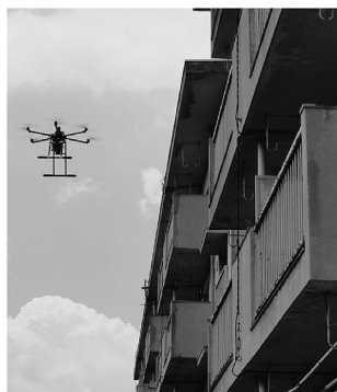
図 4 ドローンによる建物劣化調査
