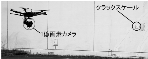
図11 ドローンによる撮影状況
