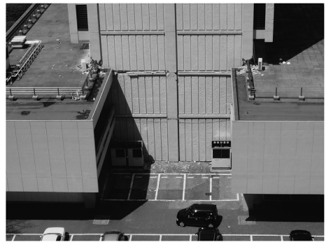
図 10 東北大学人間環境系研究棟の被災状況
