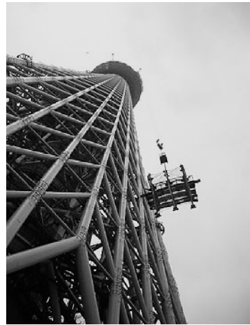
図5 クレーンによる建設部材の揚重
