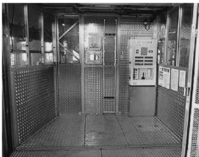
写真2 工事用エレベーターカゴ内部
