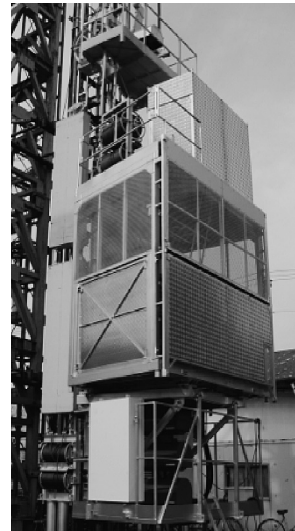
写真 1 工事用エレベーター（材料揚重用）
