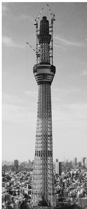
図 4 鉄骨工事中の塔体
