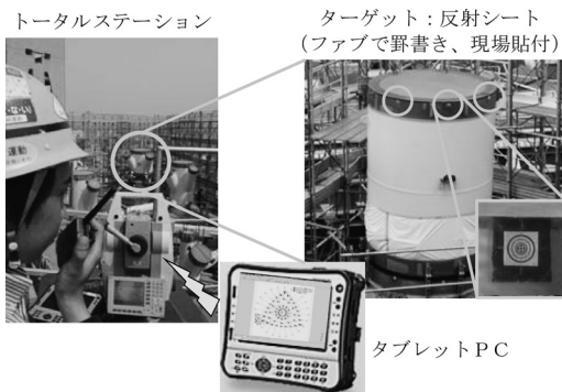
図 6 3次元計測システムによる計測作業
