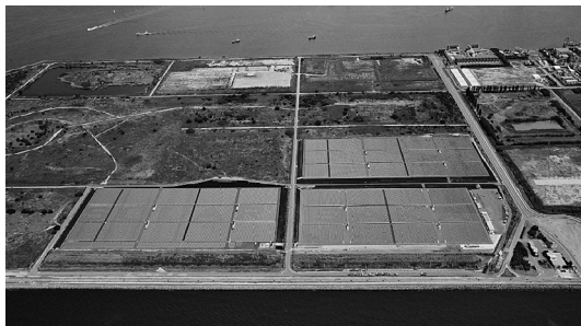
図4 堺太陽光発電所
